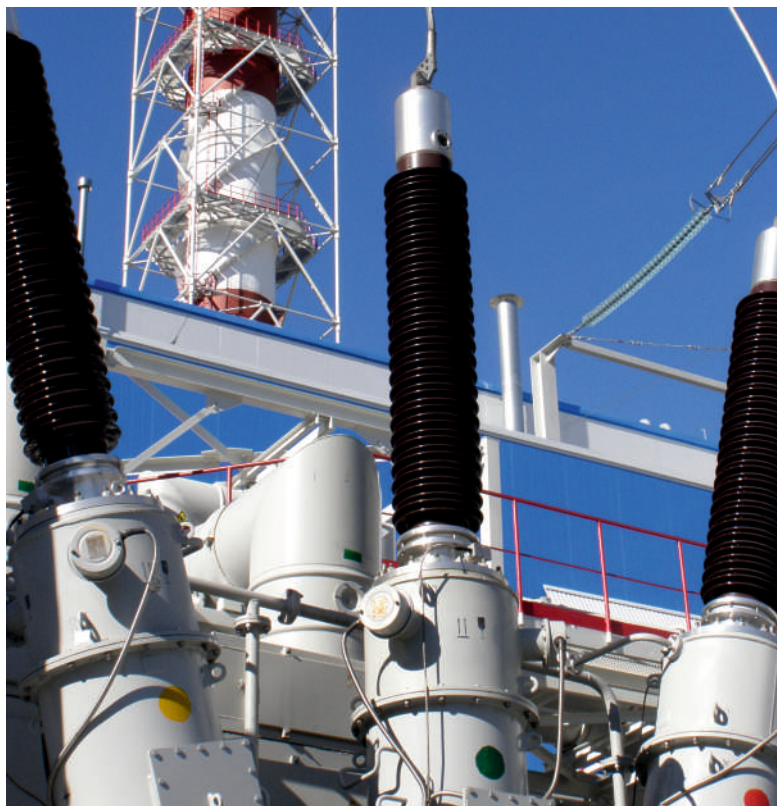
国营地区发电厂变压器上的 220 kV 套管
