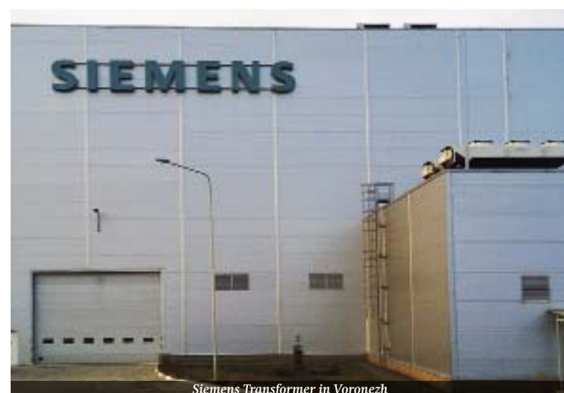
Siemens Transformer in Voronezh
