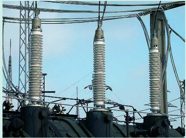
Рис. 4. Вводы 220 кВ с фарфоровой покрывкой
