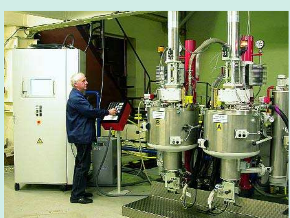
Рис. 5. Установка для подготовки и вакуумной заливки эпоксидного компаунда
